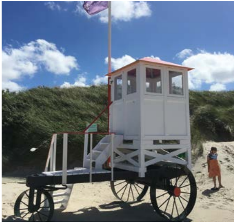
Alter Turm in neuem Glanz: Der restaurierte Badeturm auf Baltrum gilt als kleines Wahrzeichen am Badestrand der ostfriesischen Insel. Als Untergestell dient ein Teil eines Ablaufwagens der Seenotretter, wohl von 1897.
